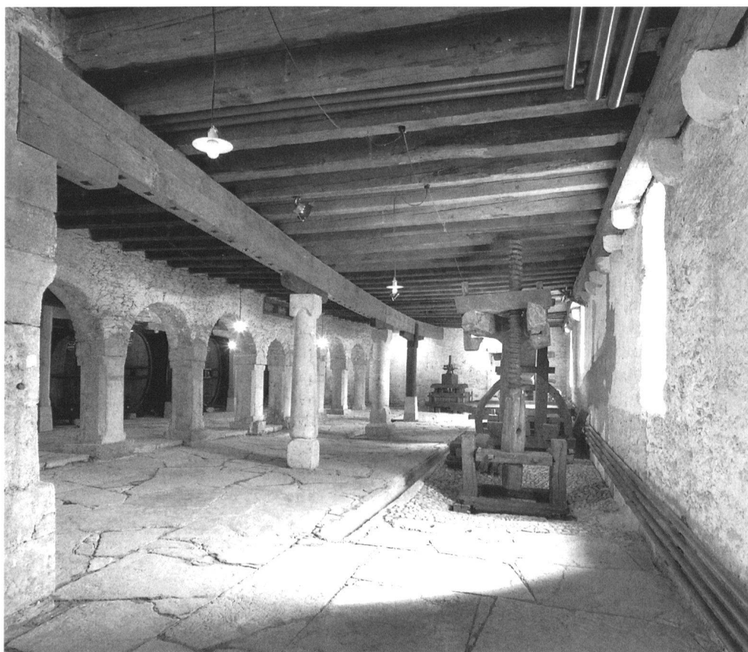
4 La Neuveville, Cour de Berne (Maison de Bellelay), Weinkeller, 1630er Jahre. – Raumeindruck der Westhälfte. Tragmauer mit Arkadenfolge, Unterzug teilweise auf wiederverwendeten Stützen des 15./16. Jh. Statische Sanierung durch die Stadt Bern 1985/1986.
