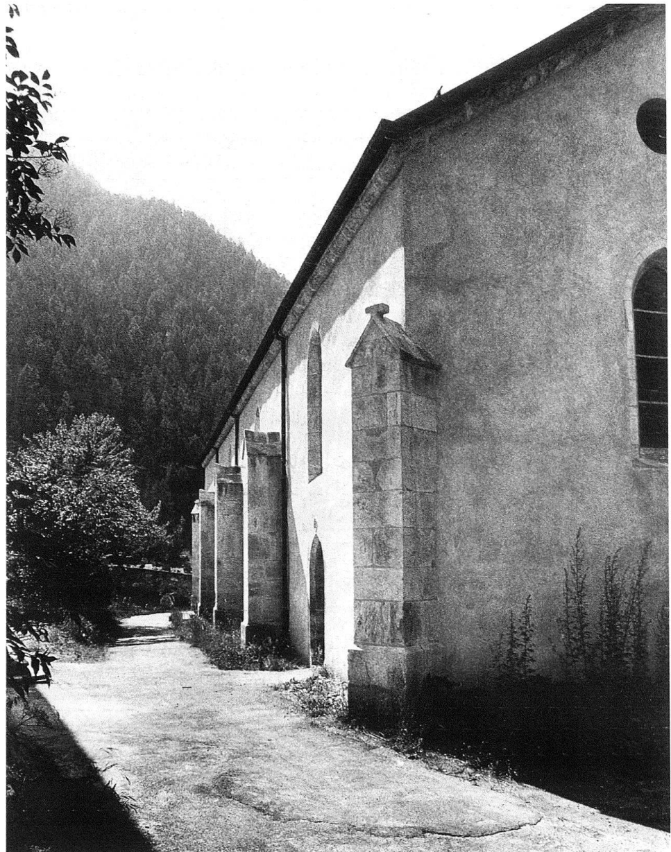
9 Le Châble (CH), Pfarrkirche St-Maurice, um 1519/20 bis 1534 (Turm um 1488 ff.), südliche Langhausflanke von Osten. Einfache Spitzbogenfenster fügen sich zwischen die regelmässigen Strebepfeiler.
