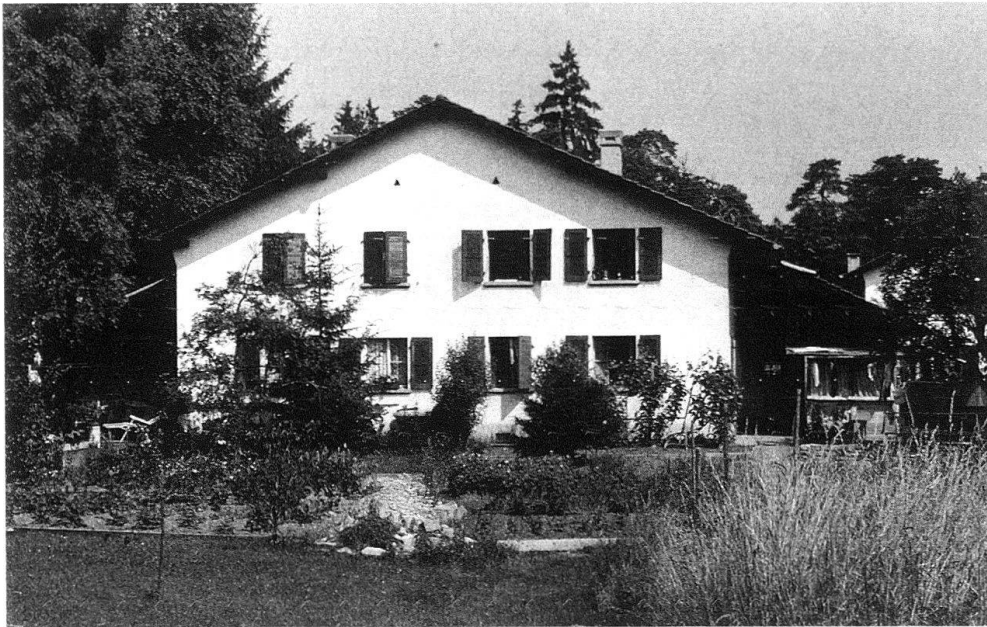
3 Lerchenfeld Thun, Siedlungsstrasse, Doppel-Dreizimmerhaus, Ostfassade mit Hausplätzen, Ziergärten, Pflanzland.
