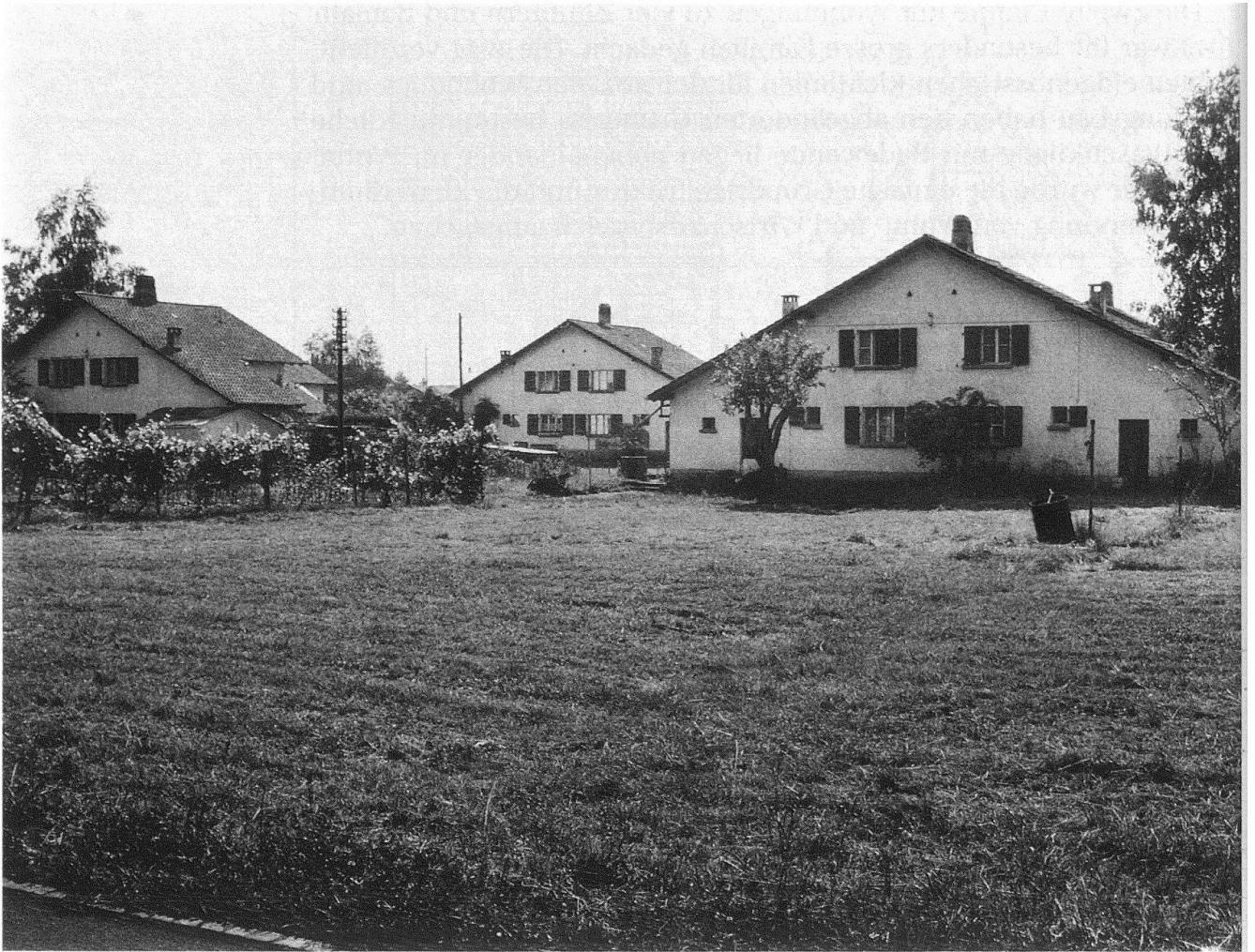
7 Lerchenfeld Thun, Siedlungsstrasse, Häusergruppe von Westen mit vorgelagertem Pflanzland.
