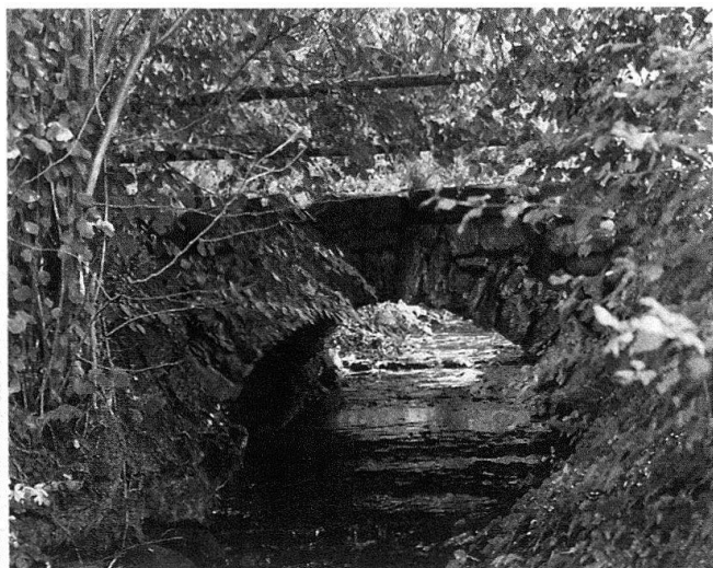
Steinbogenbrücke über den Haselbach aus dem 18. oder frühen 19. Jahrhundert
