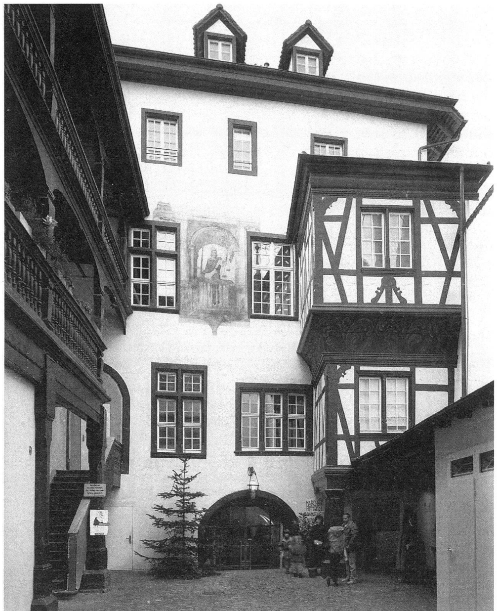
2 Vorderfassade des Spalenhofs mit Wandbild der Justitia, Fachwerkanbau des 17. Jahrhunderts und barocker Laube.
