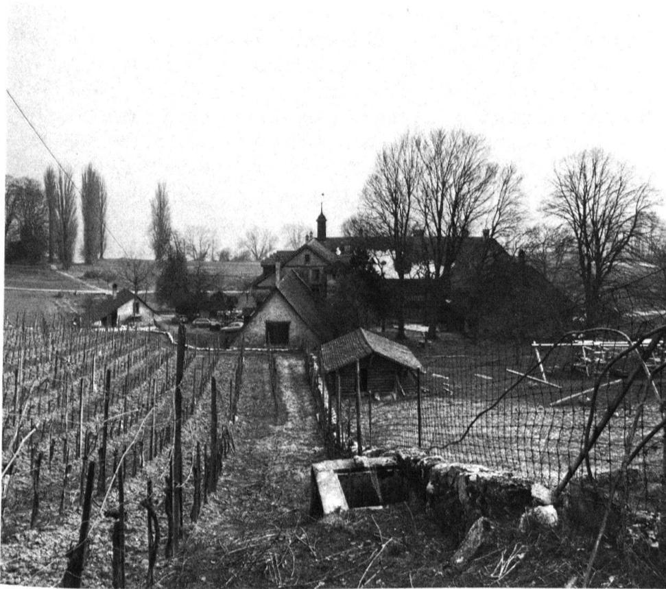
1 St. Petersinsel, ehem. Cluniazenserpriorat. Die Bauten von Norden vor der Restaurierung.
