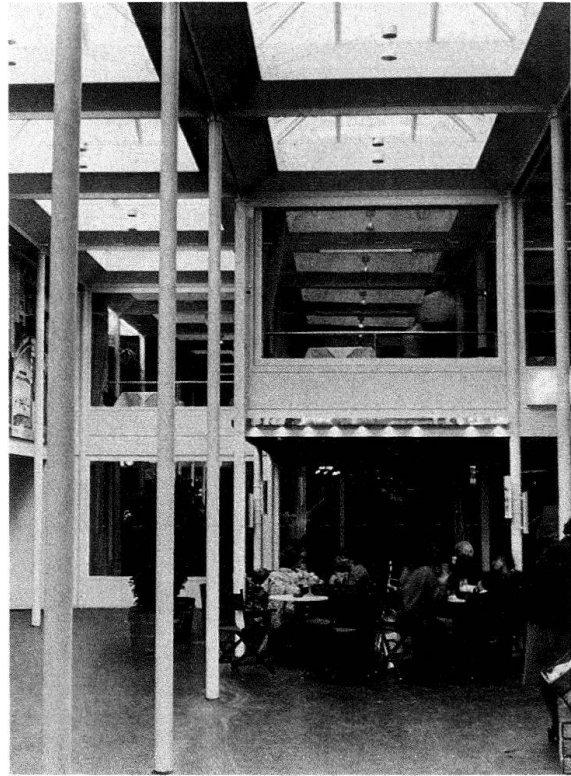
Abb. 6. Kaiser-Häuser: Verglaster Tageslicht-Hof als Zentrum der Passage
