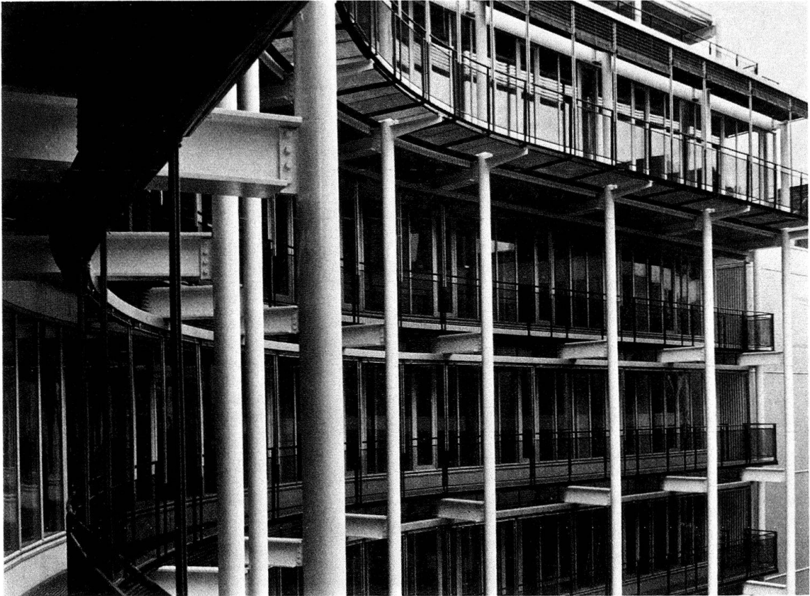
Abb. 11. Amthaus, Hoffassade des Neubautrakts
