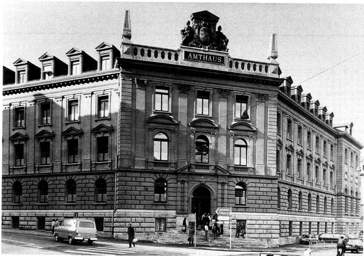
Abb. 8. Amthaus, Hauptansicht nach Restaurierung
