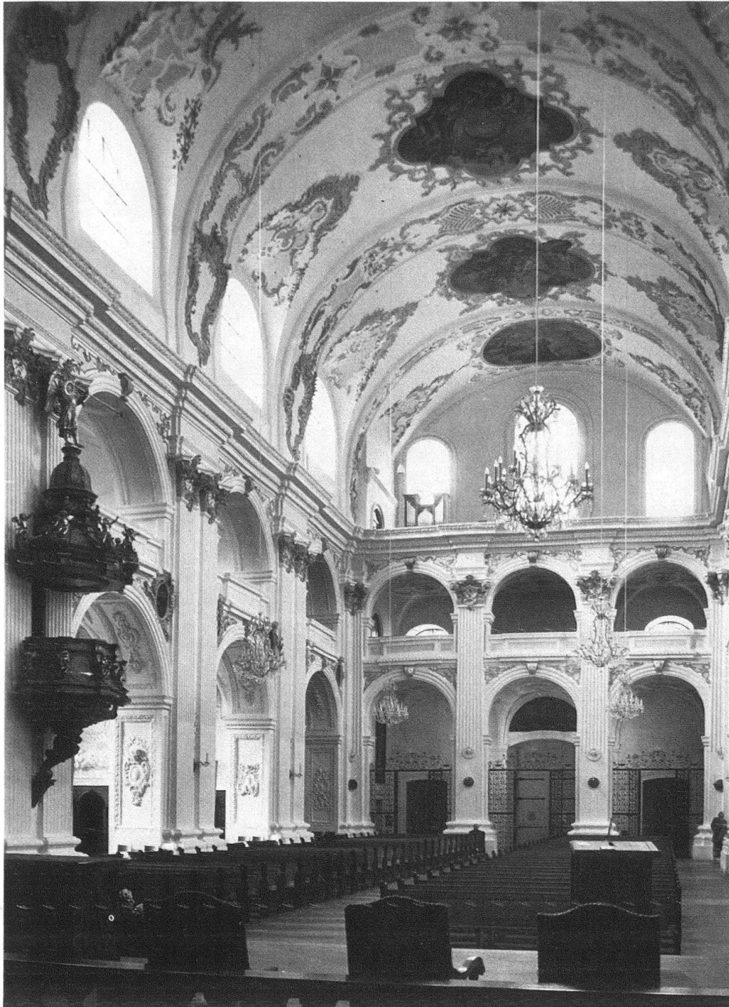
Abb. 2. Luzern, Jesuitenkirche. Inneres mit Blick gegen die Eingangspartie
