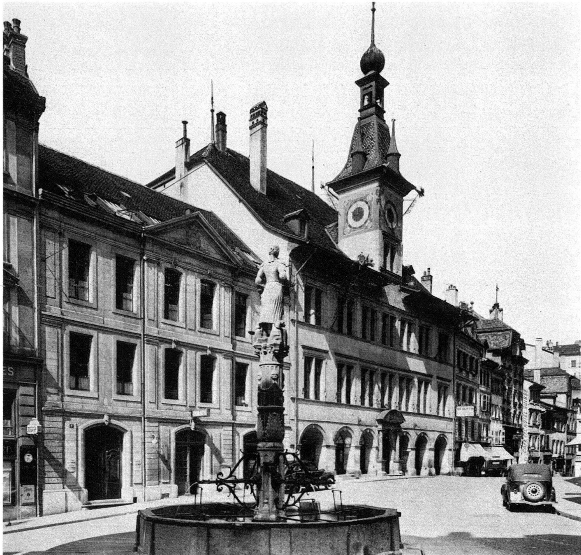
Lausanne. Hôtel de Ville de la Palud (1672/75). Le meilleur exemple d'architecture du XVII e siècle dans le Pays de Vaud
