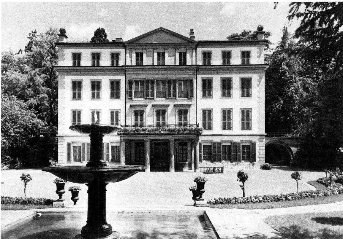
Lausanne. Villa Mon Repos (1817–1827) aménagée pour le richissime Vincent Perdonnet; façade sud avec fontaine
