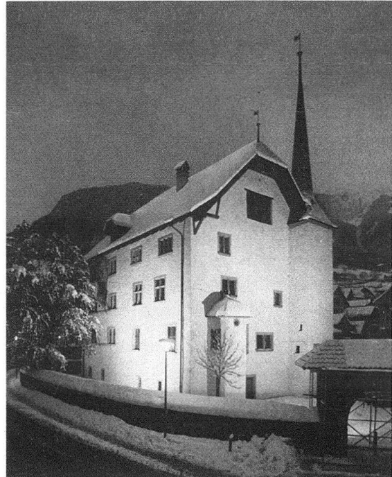
Abb. 2. Nordfassade nach der Restaurierung
