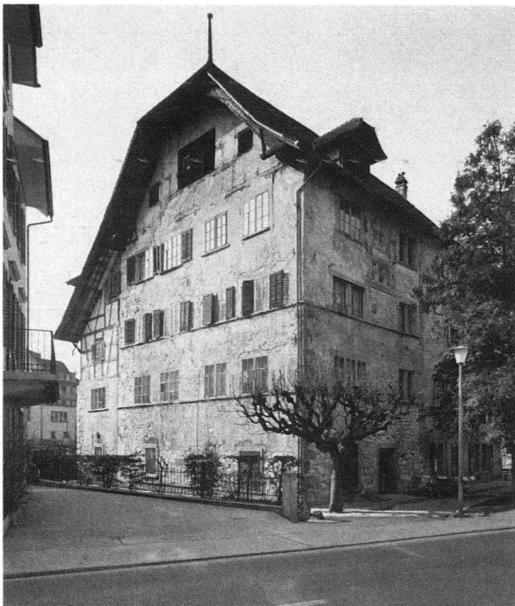
Abb. 8. Südfassade vor der Restaurierung
