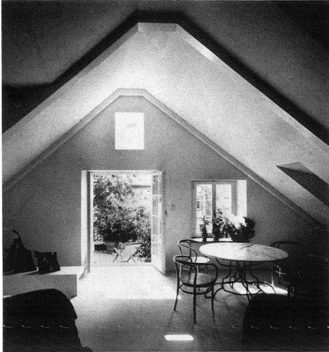
Abb. 15. Wohnzimmer der Dachwohnung mit Blick gegen die Giebelwand, erkennbar die Hetzerbalken. Im Hintergrund die kleine Dachterrasse
