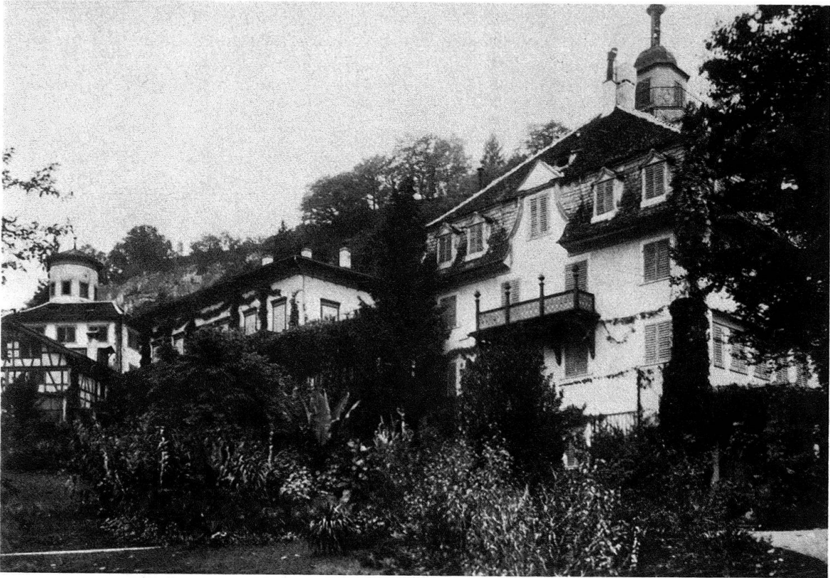
Ehemalige «Weinburg» in Thal vor dem Umbau
