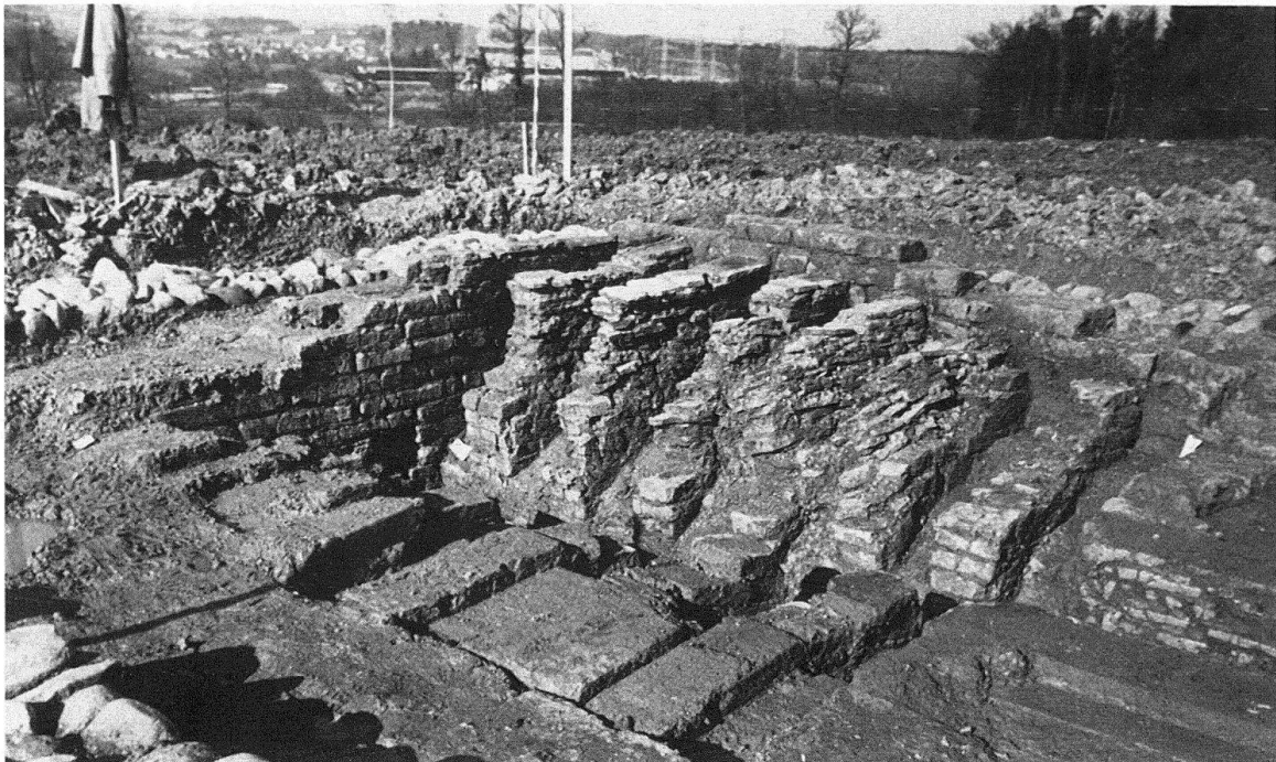
Kaisten. Feuerraum einer privaten Ziegelei
