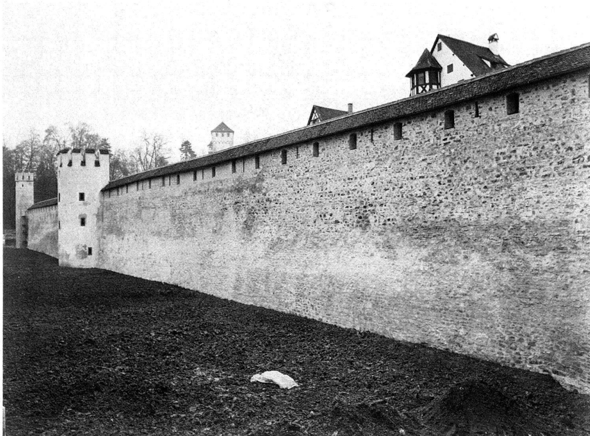
Abb. 2. Basel. Stadtmauer, Aussenseite mit verputztem Turm und «gestopfter» Mauer
