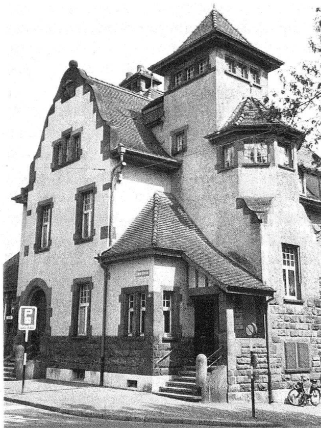
Basel. Brausebad am St.-Johann-Tor, 1905 von Architekt Theodor Hünérwadel erbaut
