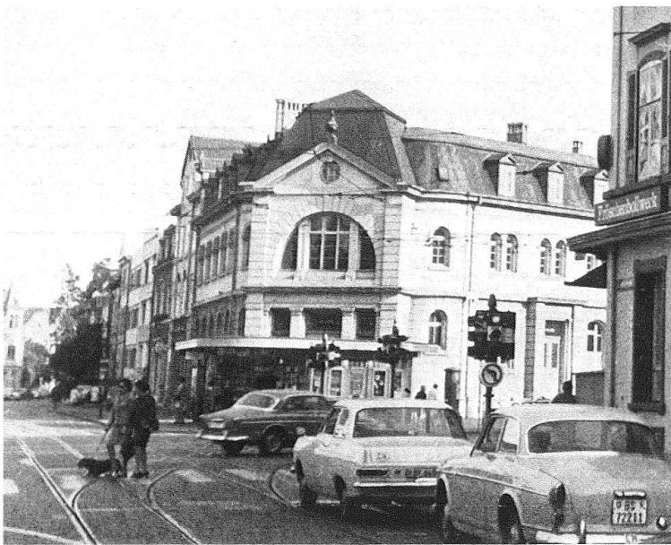
Basel. Brausebad am Spalenring, 1900 von Architekt Theodor Hünerwadel erbaut (abgebrochen)
