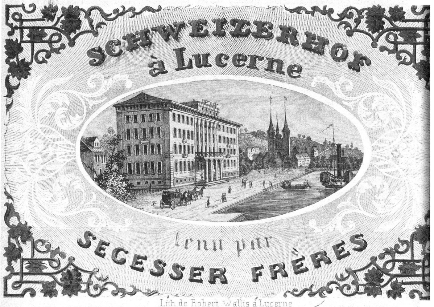
Abb. 1. Luzern. Hotel Schweizerhof. Das Hauptgebäude von 1844/45 (zeitgenössischer Prospekt)
