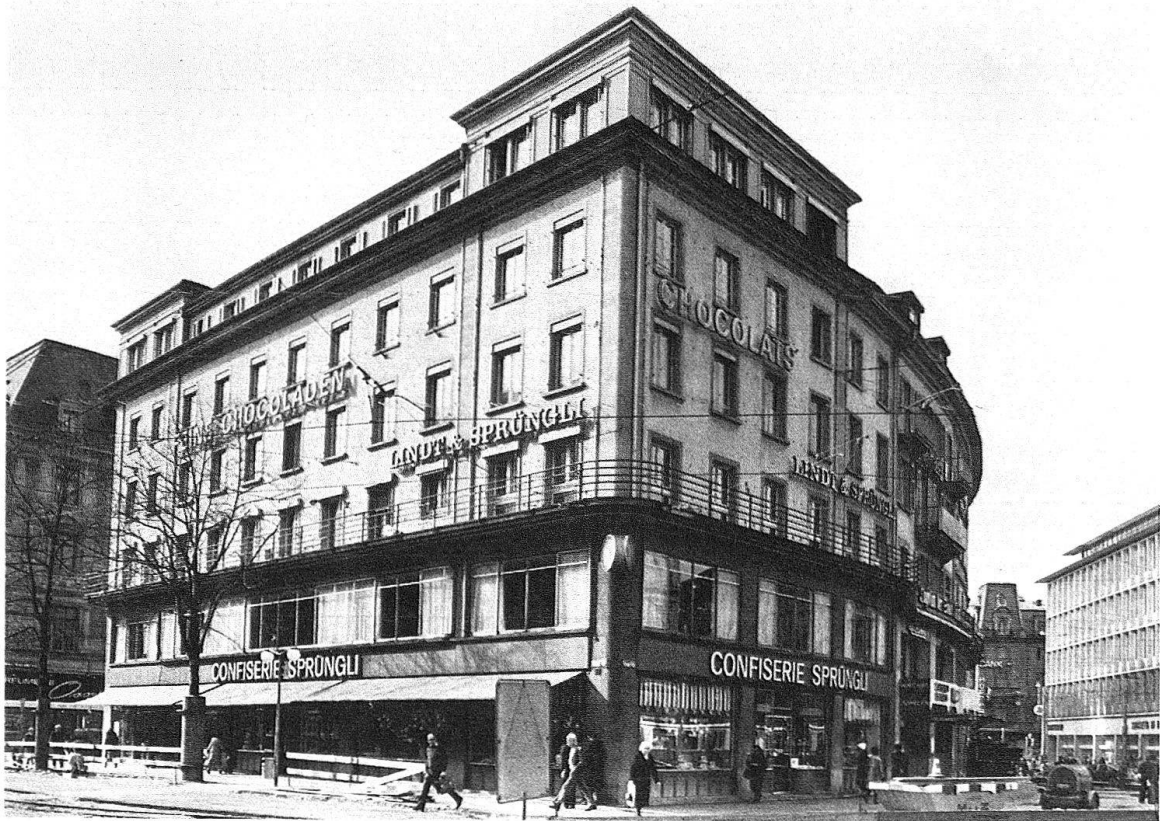
Zürich. «Sprüngli-Haus», Bahnhofstrasse 21 (am Paradeplatz), 1859 erbaut, in der Ladenfront immer wieder verändert. Oben: Fassadengestaltung 1930/31, unten: Zustand Januar 1978 nach der Restaurierung 1976/77
