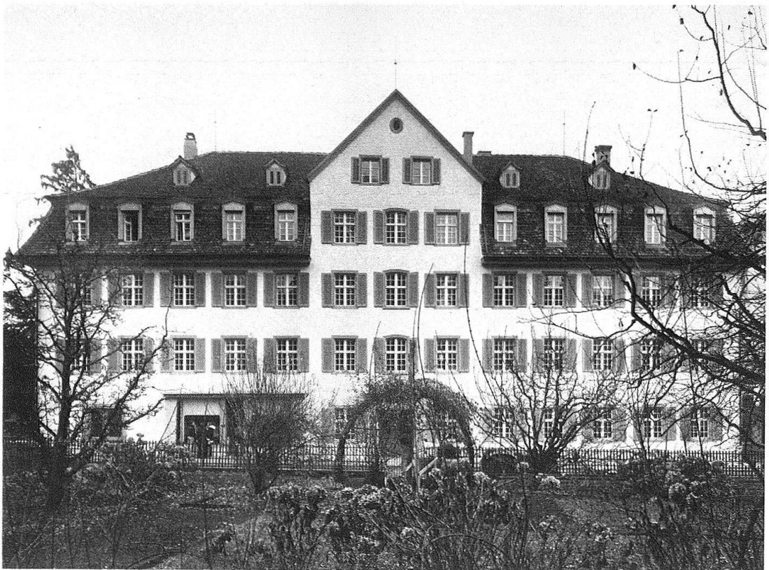
Wädenswil. Das 1814 errichtete Haus «Zur Gerbe» (Gerbestrasse 6), nach der Restaurierung
