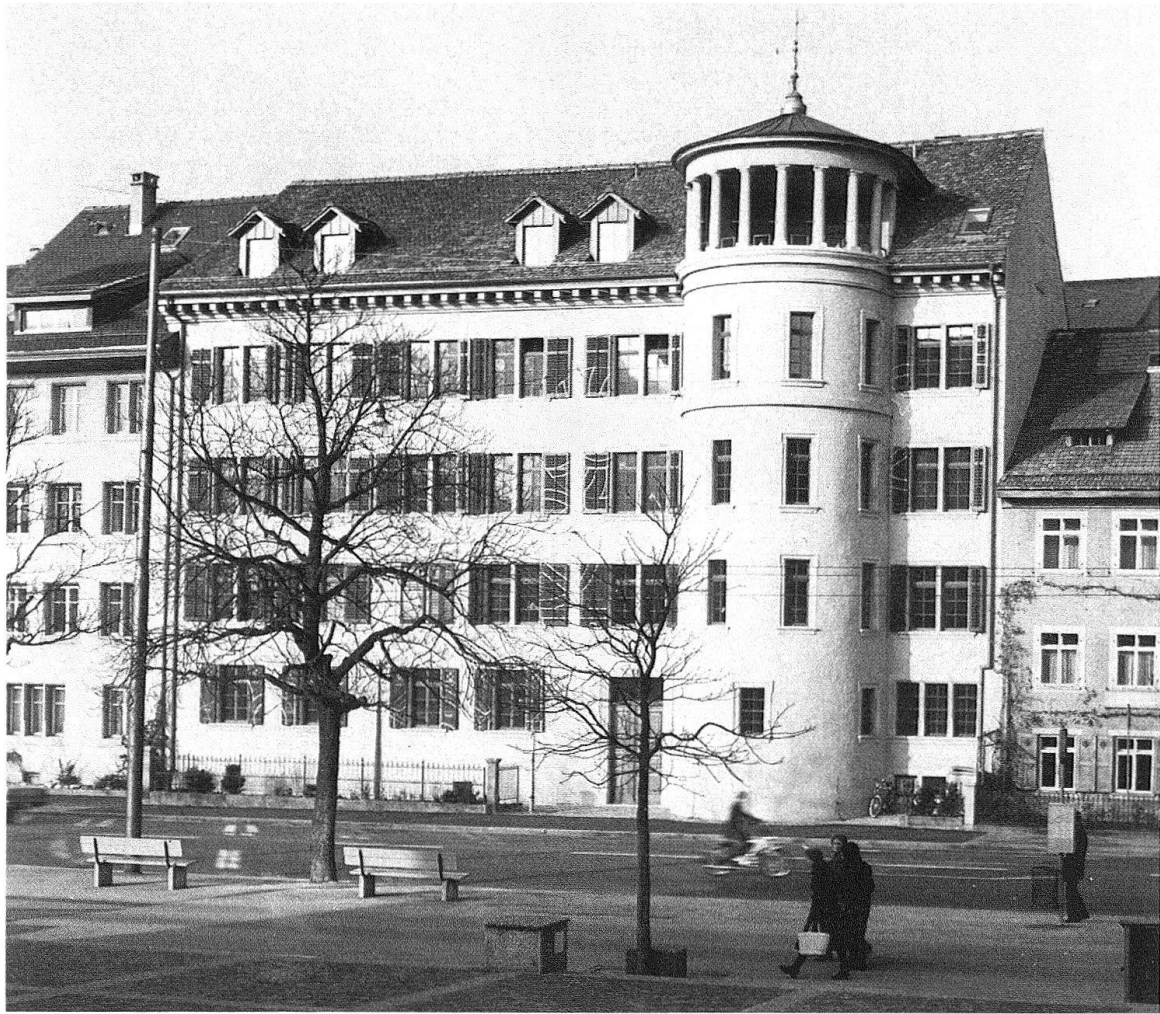
Winterthur. Haus zum «oberen Steinberg». Restauriert 1976/77 durch Architekt H. R. Lanz
