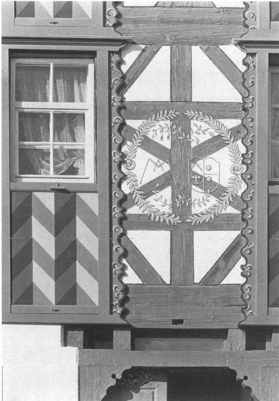
Netstal, Stähli-Haus. 1728 erbaut, 1974/75 restauriert
