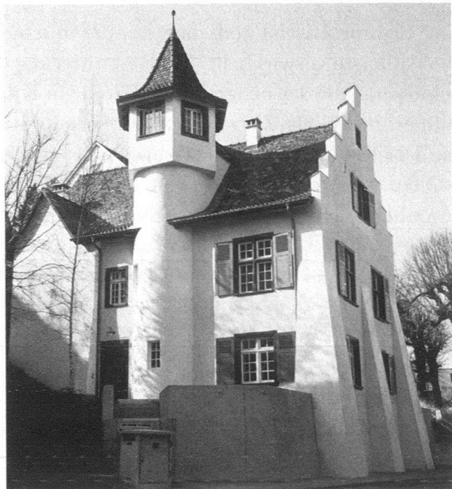
Binningen, Holeschlössli. Das im 16. Jahrhundert als Landsitz erbaute und während Jahrzehnten vernachlässigte Schlössli, leider nurmehr Fragment eines grösseren Komplexes, wurde vollständig restauriert und unter Denkmalschutz gestellt
