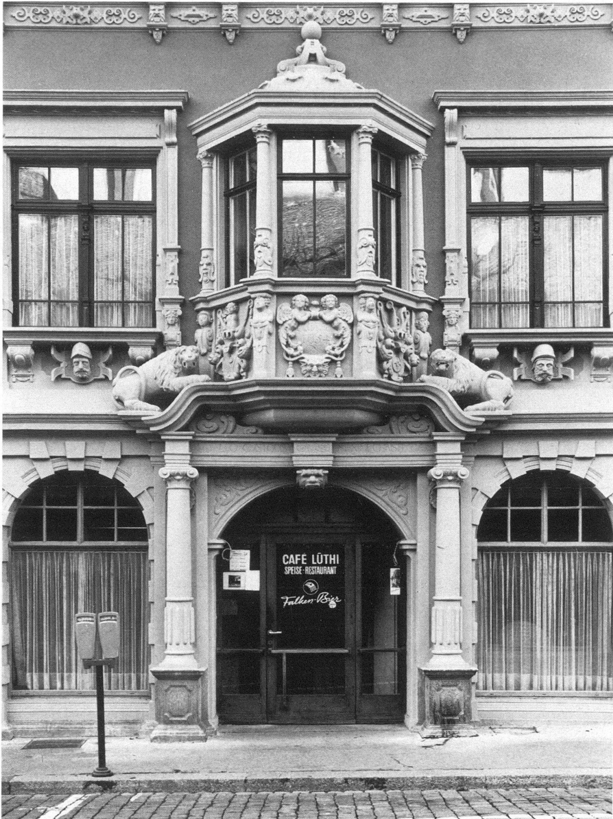
Schaffhausen. Haus zum Sittich. Das Portal mit dem Erker – 1653/55 von Bildhauer Lorenz Schreiber; die Fassade 1870 durch Stadtbaumeister Johann Gottfried Meyer in Neurenaissance umgestaltet. Restauriert 1975
