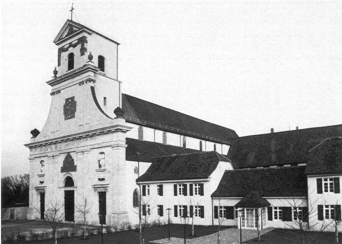
Mariastein. Die Kolossalfassade der Kirche (1880) und die neue Abtei; Restaurierung im Gange
