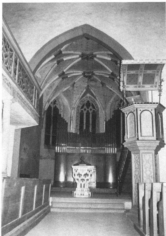
Hallau, Bergkirche St. Moritz. Emporenbrüstung und Kanzel sollen aus dem Chorbogen gerückt, die Orgel entfernt und die spätgotischen Fresken im Chor restauriert werden
