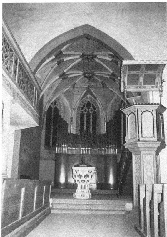
Hallau, Bergkirche St. Moritz. Emporenbrüstung und Kanzel sollen aus dem Chorbogen gerückt, die Orgel entfernt und die spätgotischen Fresken im Chor restauriert werden
