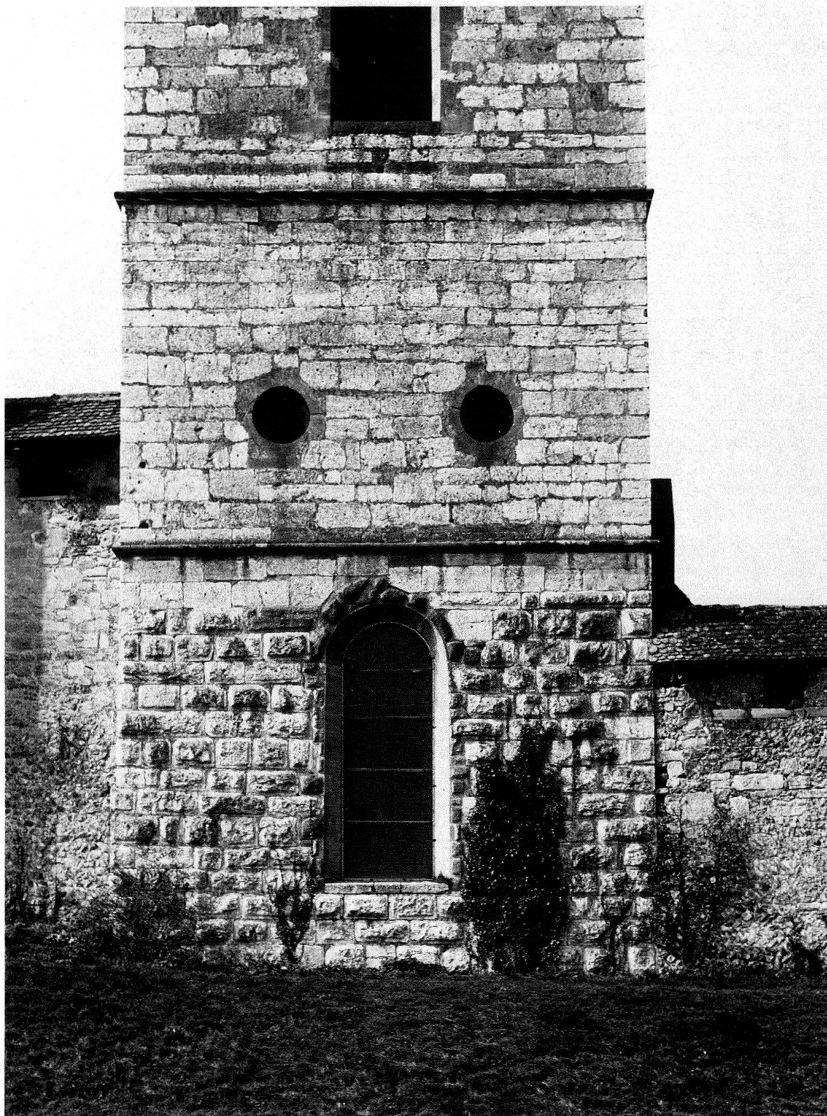
Abb. 1. Turmsockel der Deutschen Kirche von Osten. Vermutungsweise wird die Frage gestellt, ob die untersten 15 sichtbaren Steinlagen nicht ursprünglich zu einem Wehrturm aus dem 12. Jahrhundert gehören. Die Aufnahme zeigt, dass die seitlich anstossende Stadtmauer, wohl aus den dreissiger Jahren des 13. Jahrhunderts, nachträglich an den Turm angefügt und das Rundfenster später in die Wand eingebrochen worden ist.
