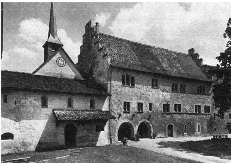
Ritterhaus Bubikon (Photo Kant. Hochbauamt Zürich)
