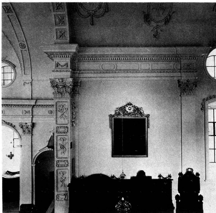
Abb. 2. Die nördliche Chorwand von Süden. Kapitelle der drei Dekorationsphasen: 1684 (Schiff), 1603 (Chorbogenpfeiler) und 1801/02 (Chorwand). Zwischen den Verkröpfungen der Stützen im Chor mit klassizistischen Stuckmotiven der kassettierte Fries von 1603
