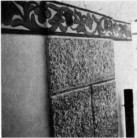
Abb. 2. Poschiavo, Reformierte Kirche. Fassade. Tuffquaderimitation 17. Jahrhundert, Farbfassung 1708
