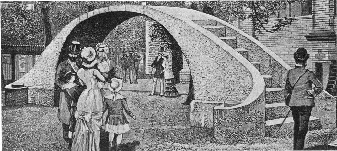
Abb. 2. Als «Teufelsbrücke» bezeichnete das staunende Publikum der Schweizerischen Landesausstellung in Zürich 1883 diese Betonbrücke mit 6 m Spannweite und nur 10 cm Scheiteldicke. – Bildquelle: *Offizielle Zeitung der schweizerischen Landesausstellung*, Zürich 1883, S. 394
