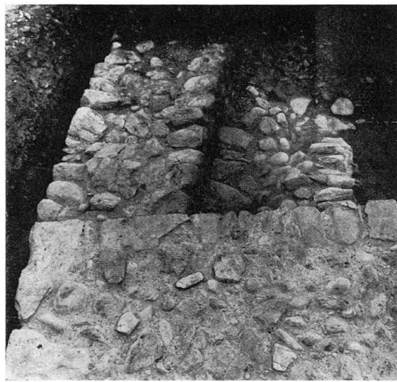
Fig. 5. Hermance. Détail des fondations du mur de fortification et de la tour
