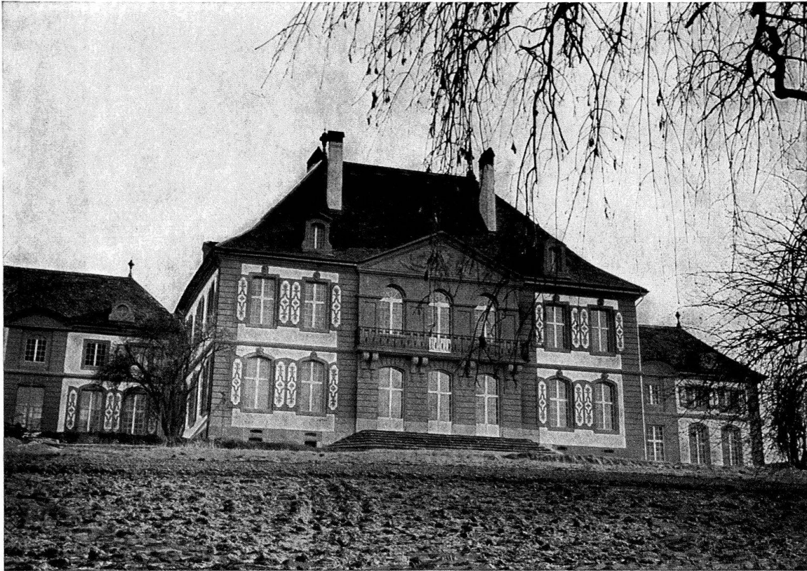
Schloß Hindelbank von Norden, nach Restaurierung des Äußern 1964
