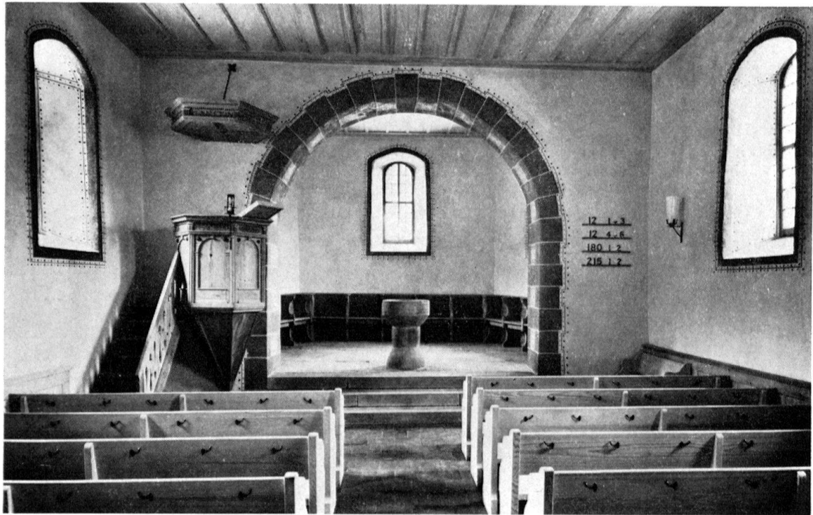
Schangnau, Kirche, erbaut 1618, nach der Restaurierung 1966
