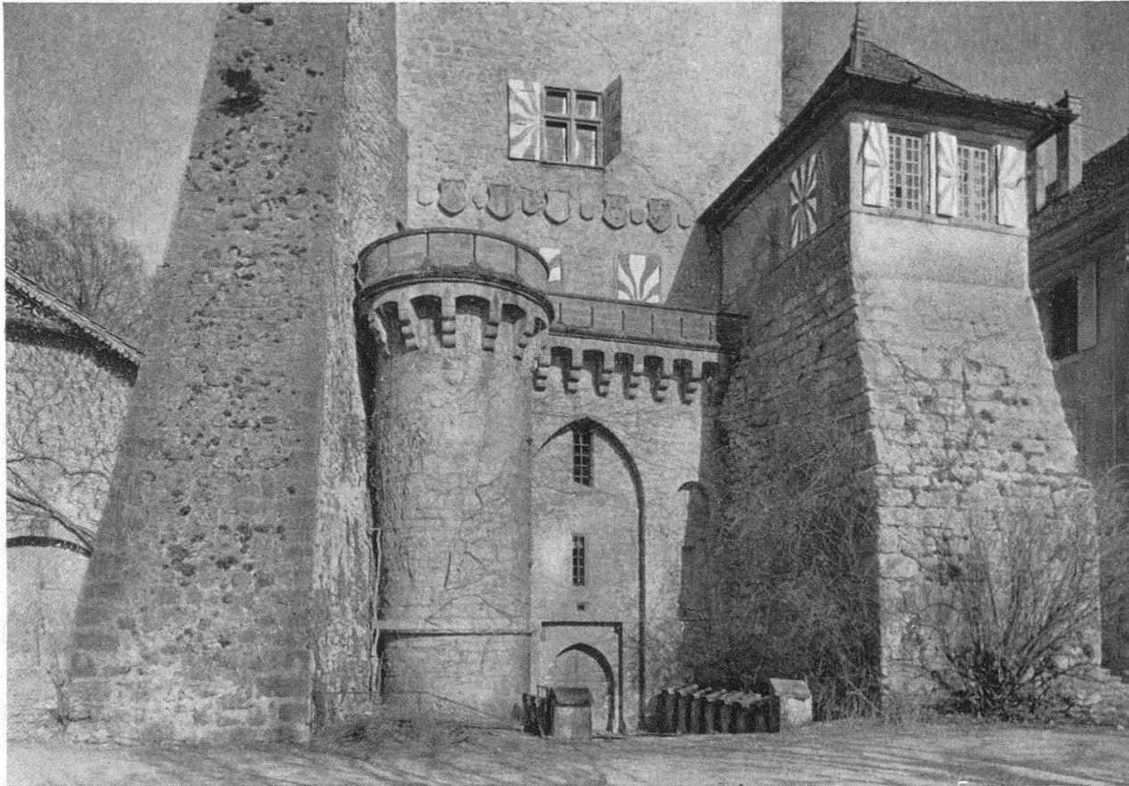
Vaumarcus, la base du vieux château, aménagée en 1893 entre deux contreforts du moyen-âge
