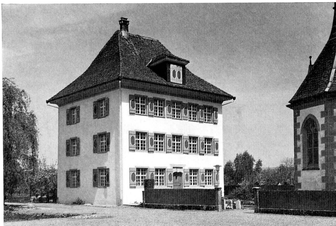
Merenschwand. Kaplanei nach der Restauration von 1962/63
