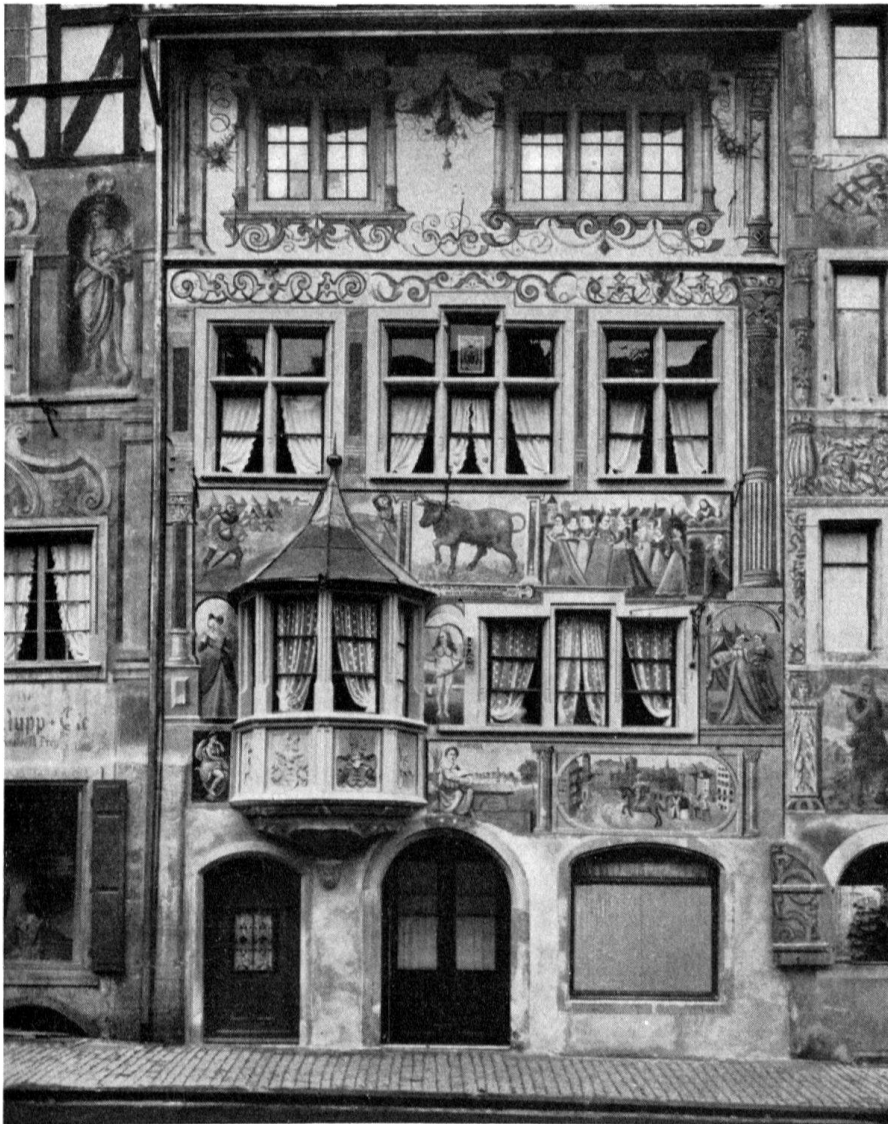
Stein a. Rh., Roter Ochsen, Fassade von 1615 nach der Wiederherstellung
