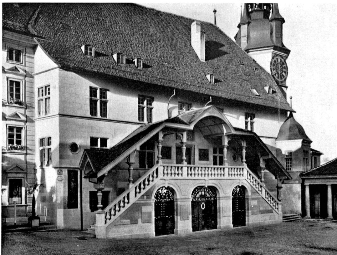
L'hôtel de ville de Fribourg après la restauration
