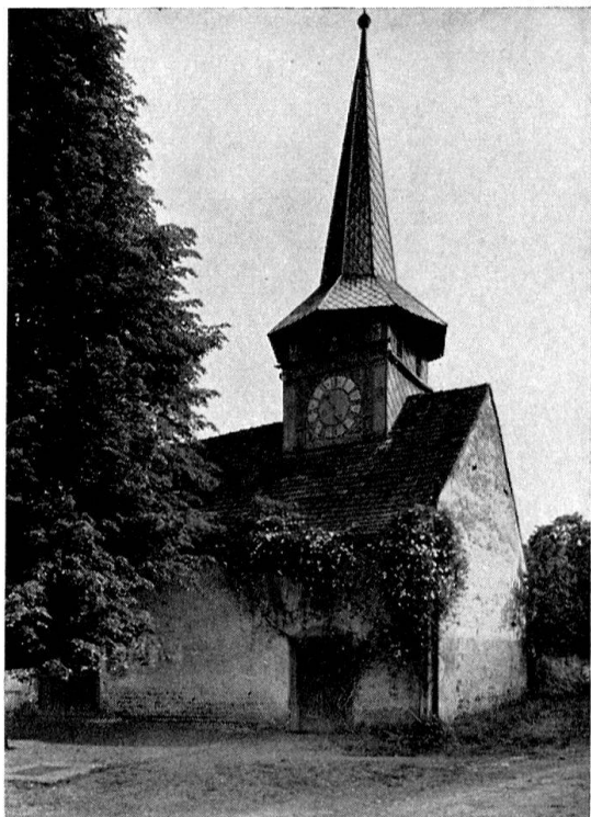
Triboltingen, Kapelle (Kanton Thurgau). Vor der Restauration
