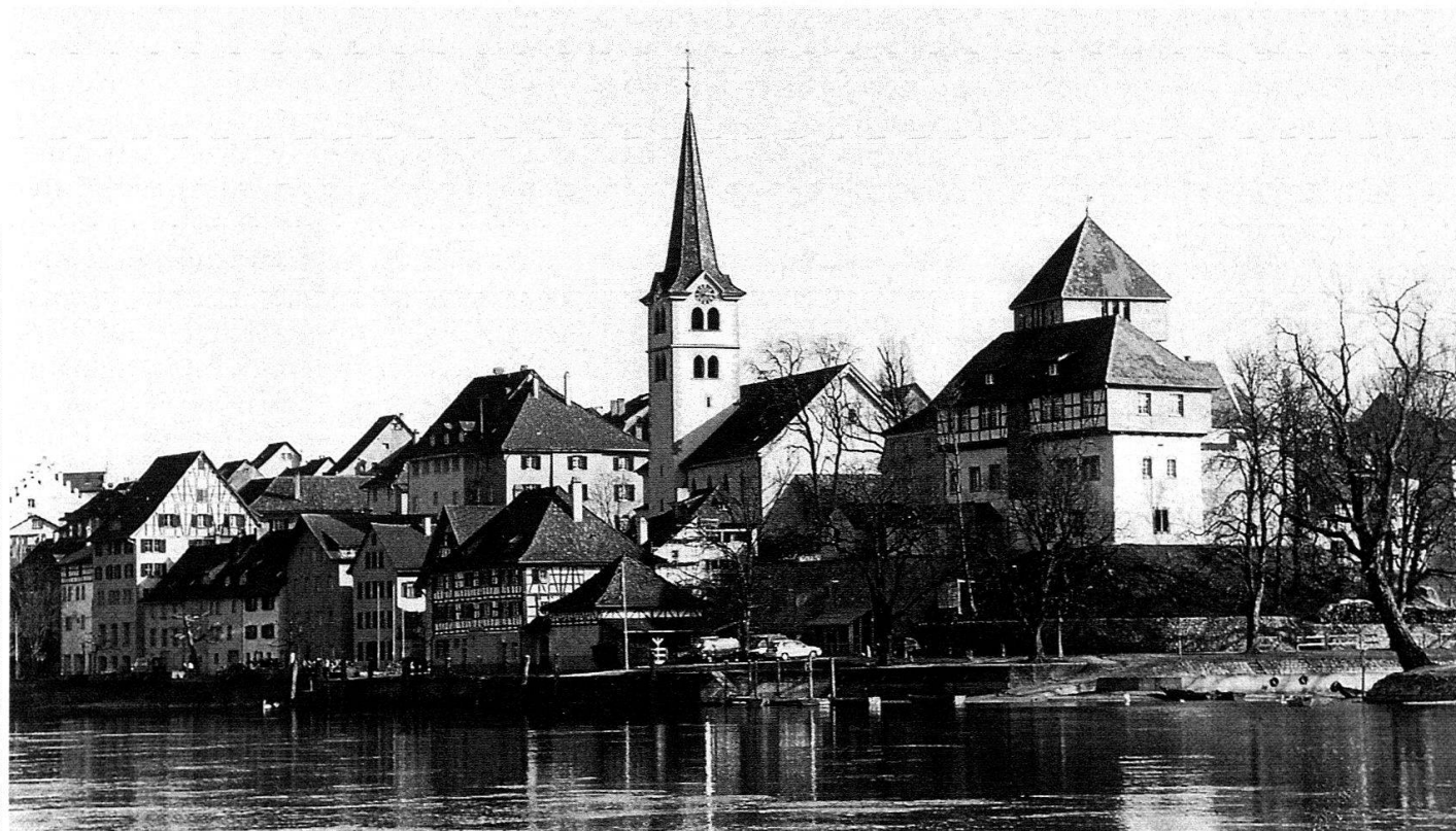
Diessenhofen, Blick von Norden Richtung Stadt mit der ehemaligen Burg Unterhof nach dem Wiederaufbau und mit der evangelischen Stadtkirche St. Dionys.
