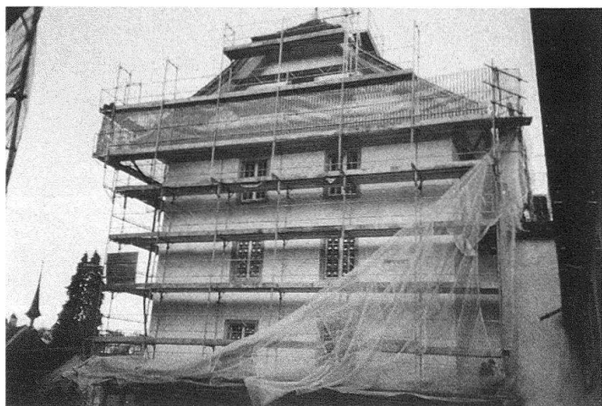
Luzern, die Propstei im Hof während der Restaurierung 1992/93.
