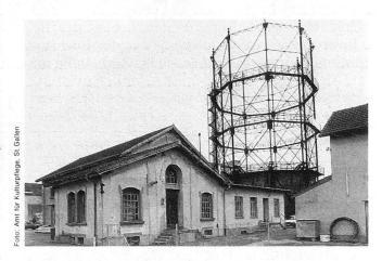
Die hochaufragende, filigrane Eisenkonstruktion verfügte über eine Wendeltreppe, welche die drei Service-Gänge und die Kuppel erschloss. Die drei umlaufenden, begehbaren Gänge waren mit aus Rautenmotiven gebildeten Eisengeländern versehen. Die vertikalen Führungssäulen bestanden aus Doppel-T-Walzeisenprofilen, zuoberst bekrönt mit dekorativen runden Aufsätzen.
