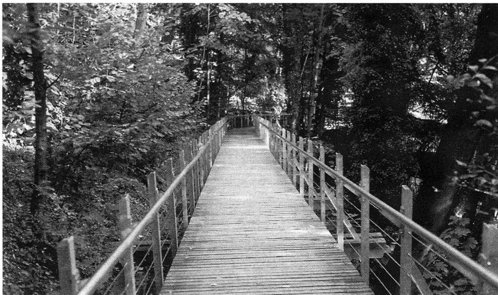
5 Der neu erstellte Zugang: der Steg zur Breite.
