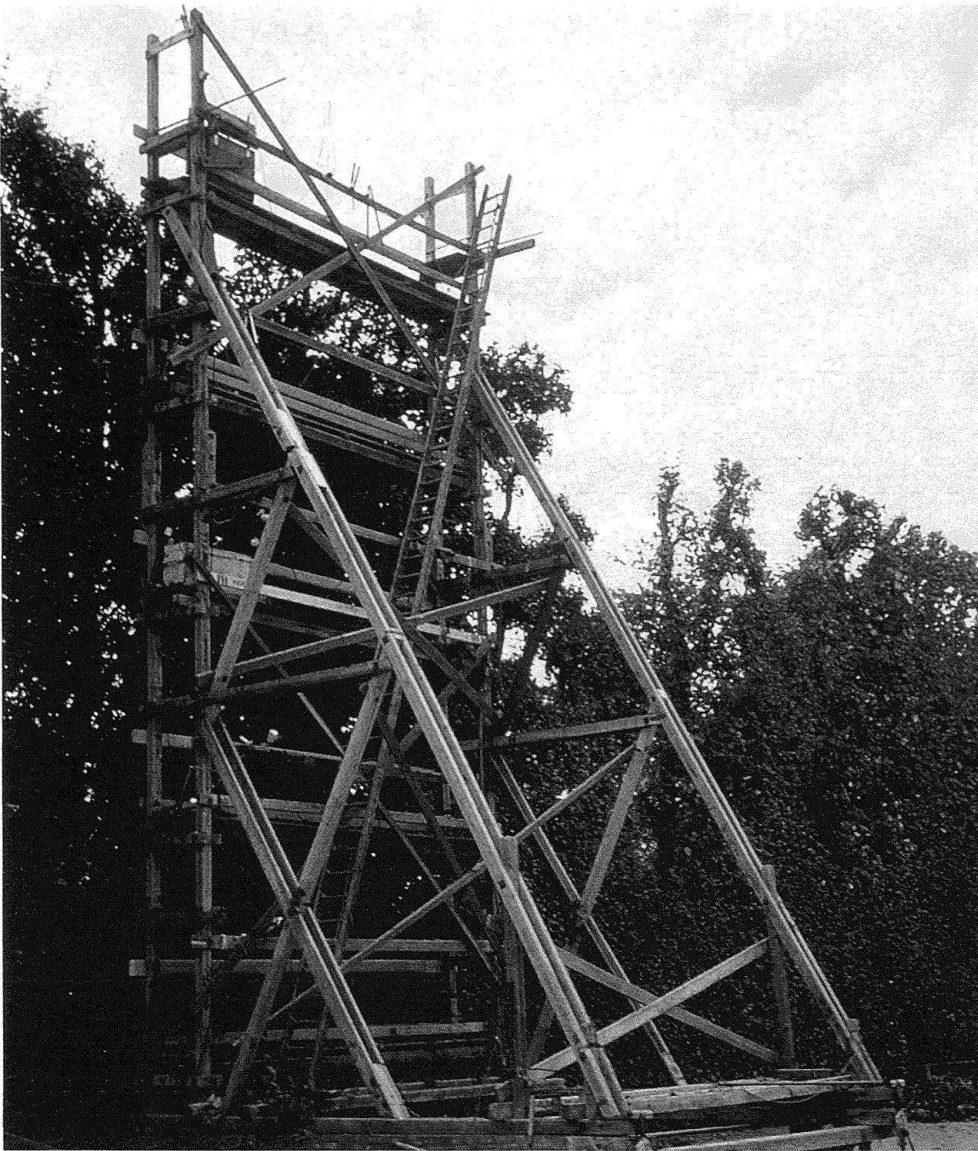
4 Wien, Schönbrunn. Gerüst für den Hecken- schnitt.
