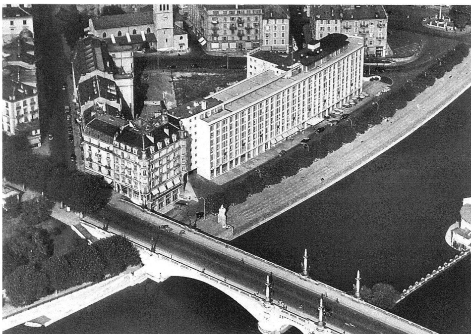
7 Genève, L'Hôtel du Rhône au quai du Seujet, construit par Marc-J. Saugey de 1947 à 1950.
