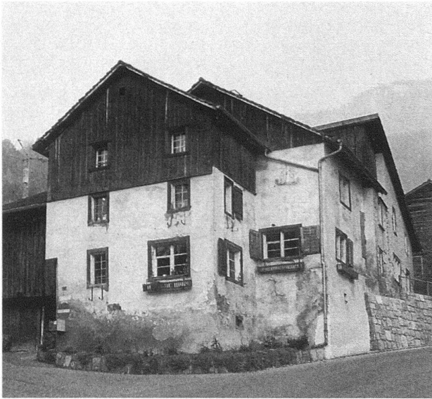
5 Häusergruppe Nr. 46 und 47 in Triesen. Baulicher Zustand vor Inangriffnahme der Sanierungs- und Neubaurbeiten.
