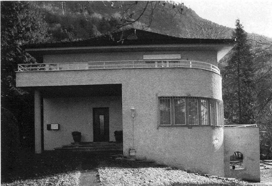
2 Vaduz, Wohnhaus an der Fürst-Johannes-Strasse 1, 1930. Architekt: Ernst Sommerlad. Das Wohnhaus gilt als typischer Vertreter der modernen Architektur: einfacher Baukörper, rechteckiger Grundriss mit eingeschobenen Formelementen, flachem Walmdach sowie eleganter Situierung in einer Parkanlage.
