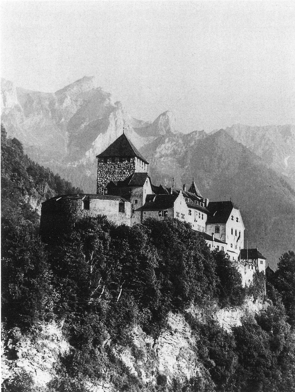
12 Das wiederaufgebaute Schloss Vaduz von Nordwesten. Deutlich überragt der Bergfried die anderen Gebäude, der südwestliche Saalbau (rechts) wurde aufgestockt und hat einen Krüppelwalm bekommen.
