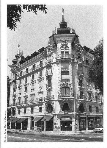
l'une en 1971, le bâtiment a peu à peu perdu son décor d'origine. Une réfection des toitures, rendue nécessaire du fait d'infiltrations d'eau, a permis, suite à une recherche documentaire conduite par le service des monuments et sites, le rétablissement presque complet de l'état ancien. Des tuiles vernissées ont été fabriquées selon le modèle d'origine posé sur ce bâtiment, les ferblanteries étant restituées sur la base des plans et de photos anciennes.
