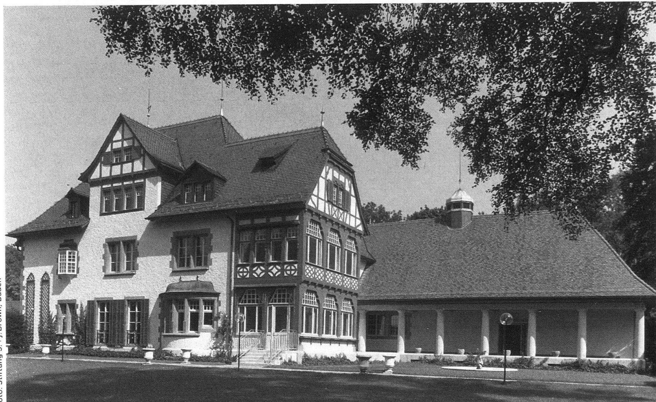
Baden, Wohnhaus von Sidney und Jenny Brown-Sulzer, 1900–1906 von Moser und Curjel erbaut, heute Sitz der Stiftung Langmatt.
