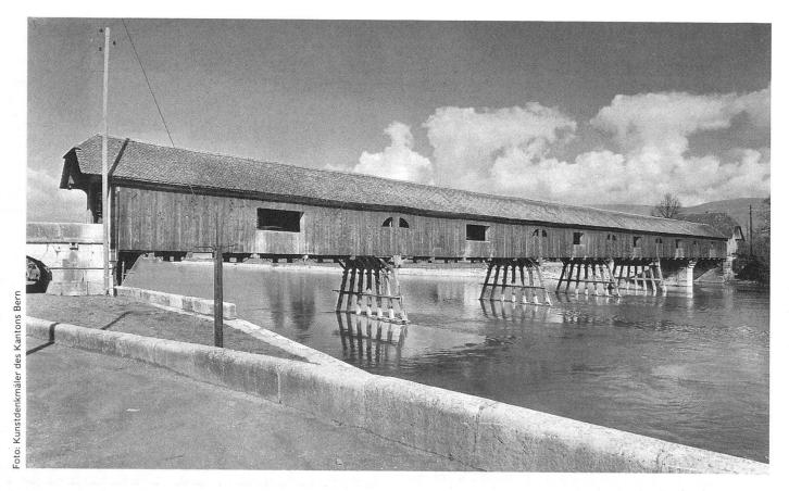
der Flussschiffahrt dienenden Ländteanlage wieder auf. Der über 100 m lange, eingewandete und gedeckte Bau überquerte die Aare mit sechs Hängewerken auf fünf Pfeilern. In der Nacht vom 4. zum 5. April 1989 fiel die Brücke einem möglicherweise politisch motivierten, verbrecherischen Brandanschlag zum Opfer und muss vollständig ersetzt werden.
