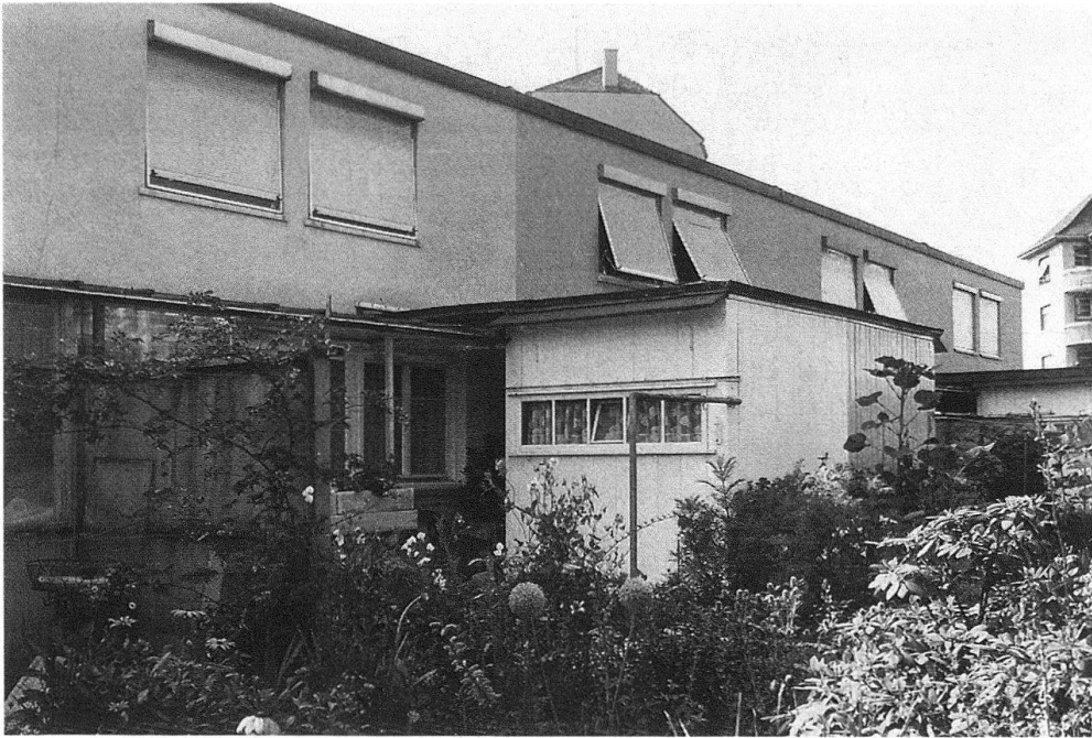
4 Wohnsiedlung Schorenmaten, Gartenseite, Zustand 1982.
