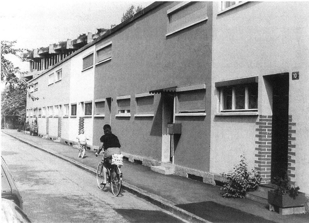
8 Individuelle Veränderungen bei den Häusern der Baugenossenschaft Rüttibrunnen.
