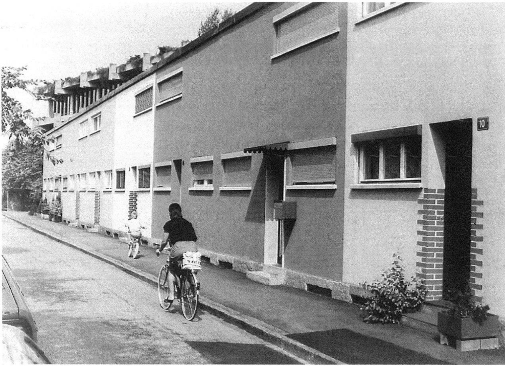
8 Individuelle Veränderungen bei den Häusern der Baugenossenschaft Rüttibrunnen.
