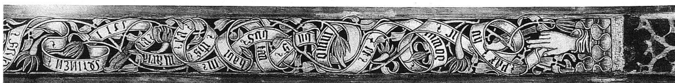
5 Maur, Decke von Hans Ininger (1511). Östliches Stück des Längsfrieses. In einer Ranke mit reicher Blütenpracht von rechts (Osten) nach links (Westen): Aus einem Wolkenkranz entrollt die segnende Hand Gottes ein Spruchband mit der Inschrift: «pax huic domui et omnibus habitan[t]ibus in ea; ih[esu]s, Maria, i[n] a[nn]o 1511; MINEN FRID SEND ICH US, ALLEN DI[IE] SO WONEND IN MINEM HUS».
