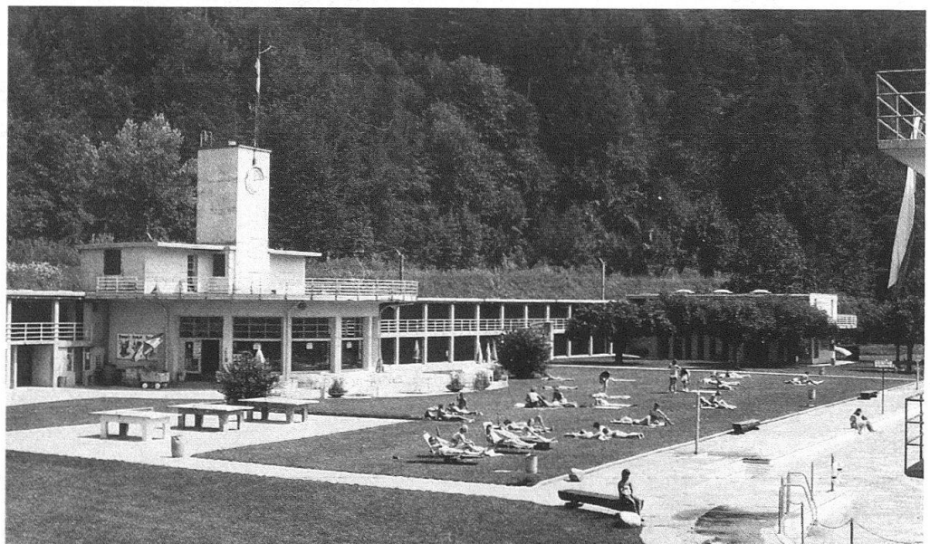
5 Strandbad Interlaken, fotografiert im Sommer 1986. Restaurant und Garderobetrakte lassen noch weitgehend den Originalzustand erkennen.
