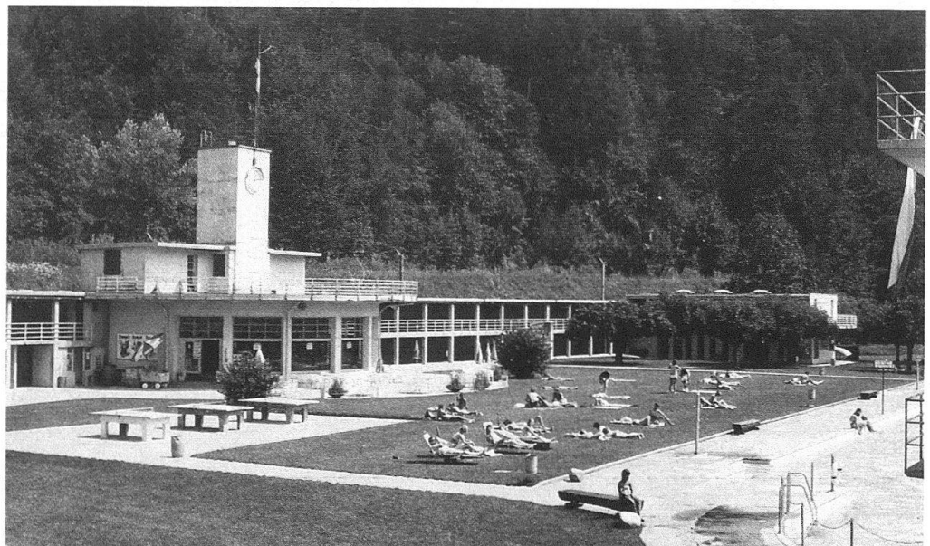
5 Strandbad Interlaken, fotografiert im Sommer 1986. Restaurant und Garderobetrakte lassen noch weitgehend den Originalzustand erkennen.
