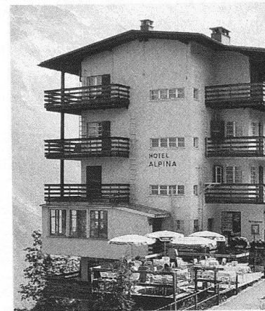
2 Das aufgestockte Hotel «Alpina» mit aufgestülptem Satteldach, fotografiert 1986.
