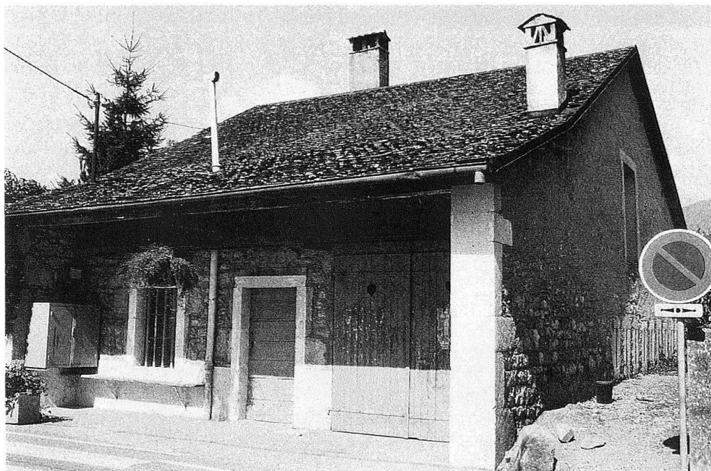
2 Fruitière de Villard (vers 1860). Premier type avec appartement à l'étage. Le couvert à gauche date de la fin du XIX e siècle.
