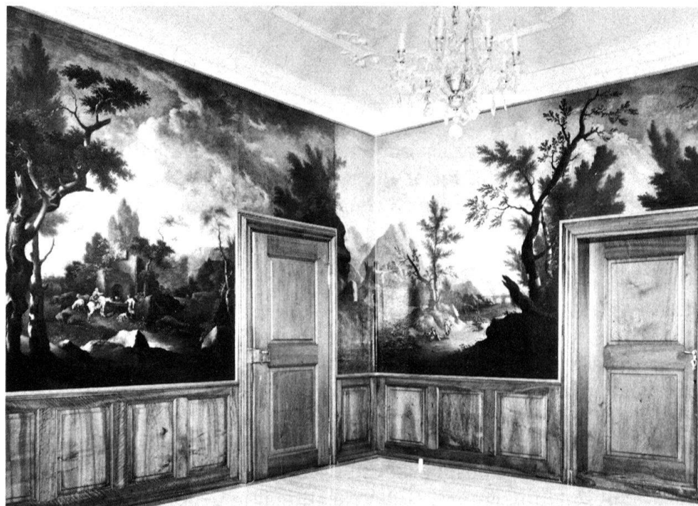
5 «Sonnenhof», Zürich [wie Abb.3, jedoch Foto nach der Restaurierung]. Die Bespannungen wur- den auf dünne handels- übliche Keilrahmen ge- spannt (Spannsystem D).
