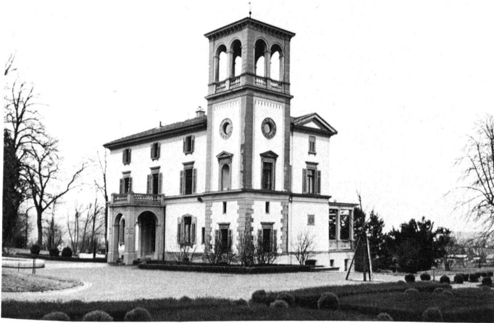
1 Gailingen, BRD, «Rheinburg»: Burghaftigkeit durch knappe Architektur, Turm und Vorhalle, die Villa von Nordwesten, nach der Erneuerung von 1977–1979.
