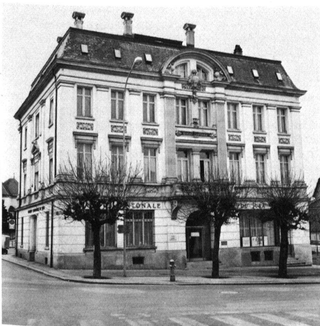
Photo: Office du patrimoine historique JU
