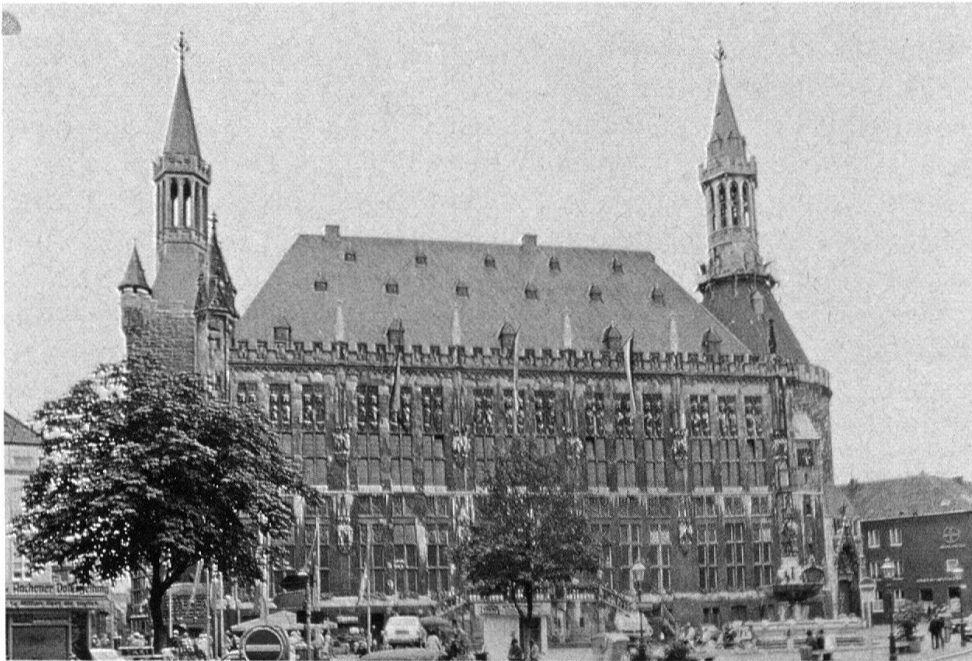
7 Rekonstruktion als nostalgischer Ersatz für die Suche nach neuen Formen: Die gotischen Turmhelme verlor das Aachener Rathaus bereits im Stadtbrand von 1656. Sie wurden vor wenigen Jahren nach alten Ansichten rekonstruiert.
